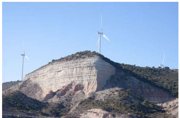
Cortado bardenero, con varios nidos de especies en peligro de extinción, afectado por la instalación de una central eólica.
